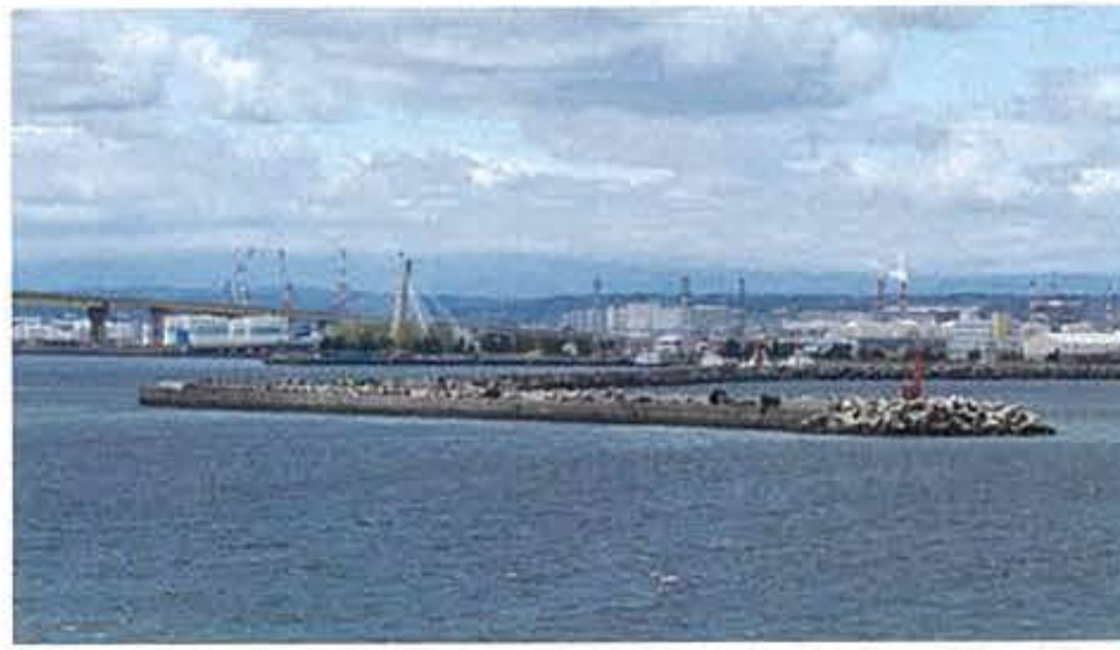
▲燕島からも見える白銀西堤防は戦跡ではありませんが、1950年に完成してから、1967年に引き上げられるまで、応急的に3隻のタンカーを沈めて作られた全国でもめずらしい「沈船防波堤」(ちんせんぼうはてい)でした。3隻のうちの2隻は未完成のタンカーでしたが、のこり1隻の「東城丸」は戦時中、資源輸送中に損傷しながらも、任務を果たしますが修理の終わらないまま終戦を迎えた船でした。
