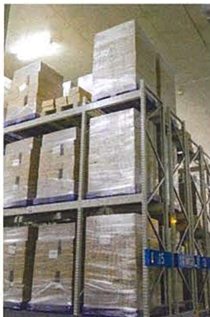
▲右端がバナナチョコアイスバー、天井が見上げるほど高く、とても広い冷凍庫。
